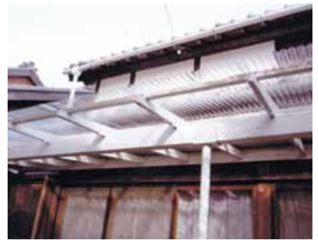
『完成しました』 野田 サッチャン 72歳の私。台風で破損した築50年のテラスの屋根を一人で新しく張り替えました。毎日眺めて達成感でいっぱいです。
